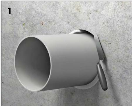
Riempire completamente la fessura anulare restante tra il tubo, oppure tra l'isolamento del tubo, e l'elemento strutturale (parete o solaio) con malta cementizia o gesso, per l'intero spessore dell'elemento strutturale.
